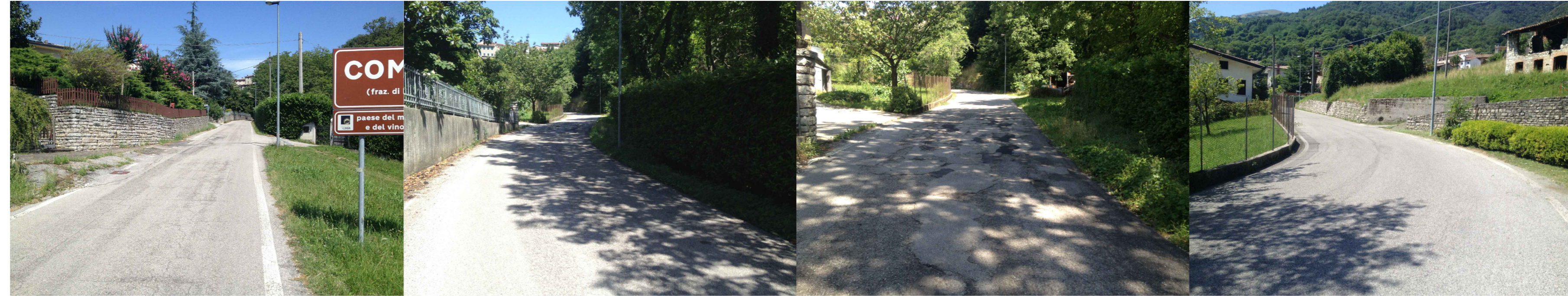
fine tratto oggetto di intervento - 1
