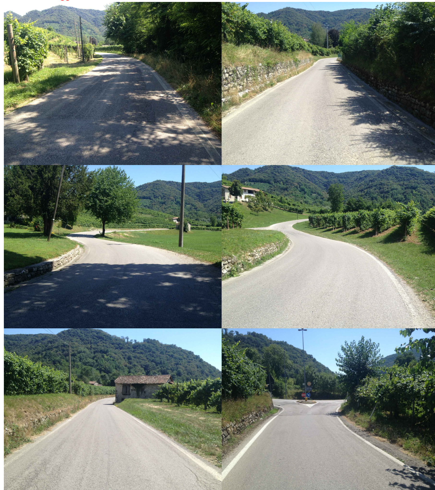
fine tratto oggetto di intervento - 2
